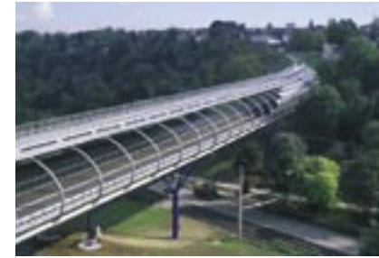
Brücke über das Nesenbachtal in Stuttgart
